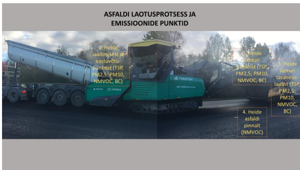
Joonis 62 Laotusprotsess ja heite mõõtepunktid
