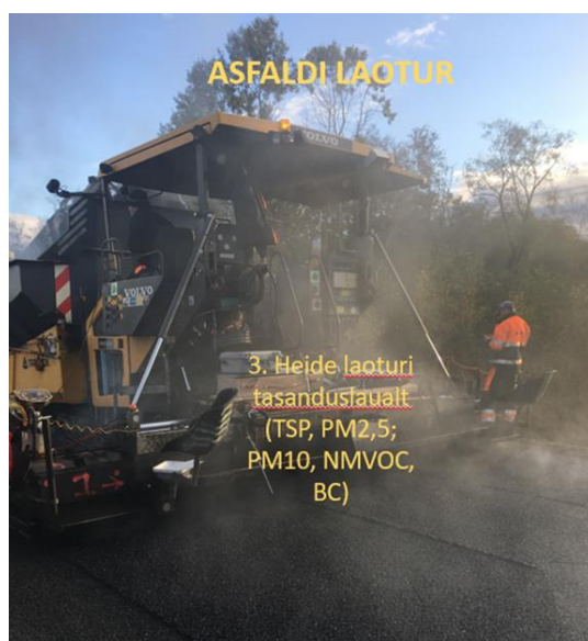
Joonis 63 Laoturi tasanduslaud ja heide
