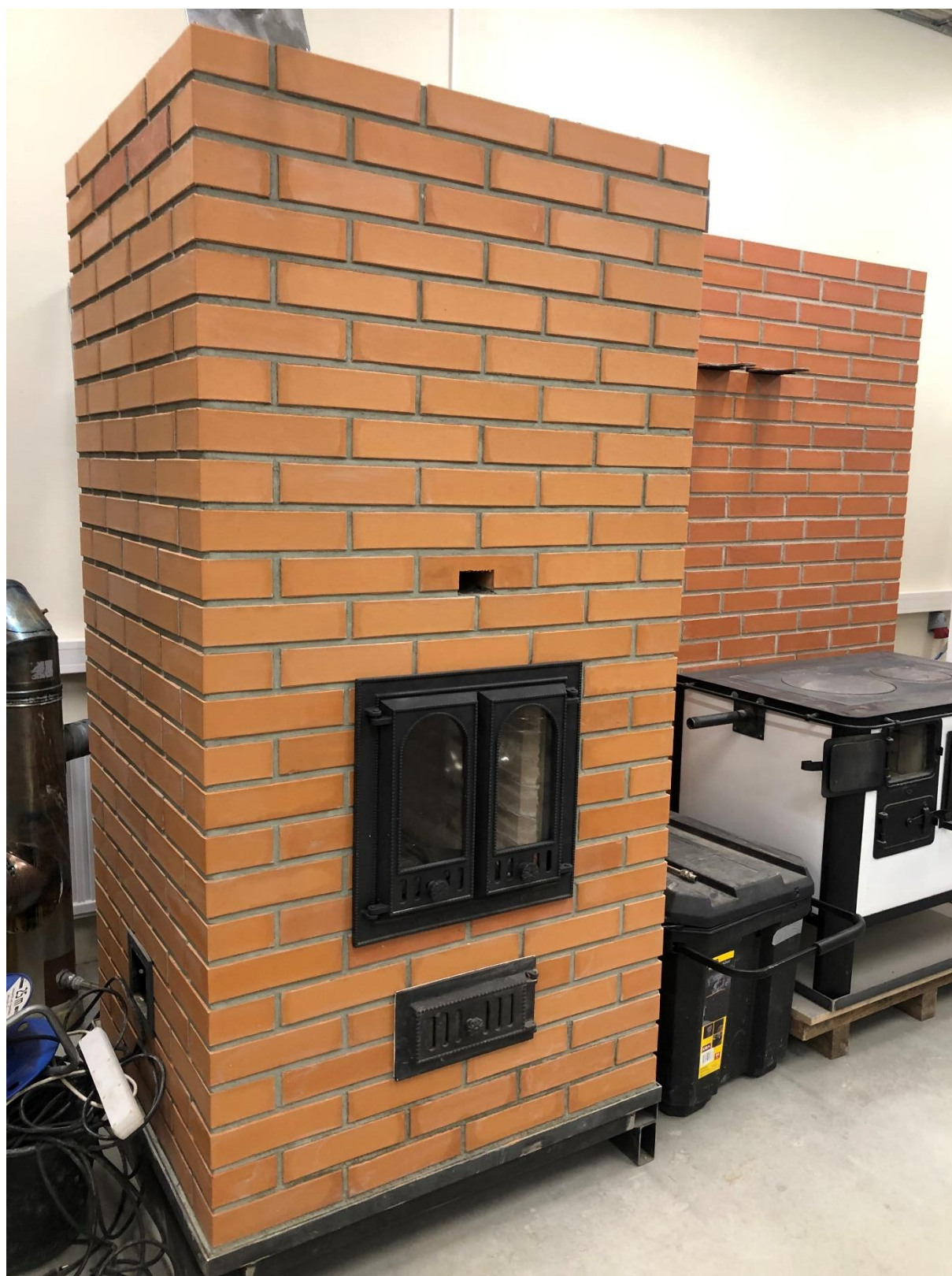
Joonis 9 Soome tüüpi restkoldega ahi
