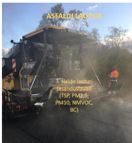
Joonis 63 Laoturi tasanduslaud ja heide
