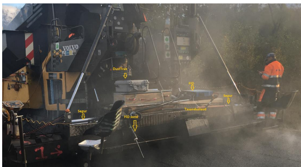
Joonis 64 Mõõtmisprotsess ja analüsaatorid laoturil
